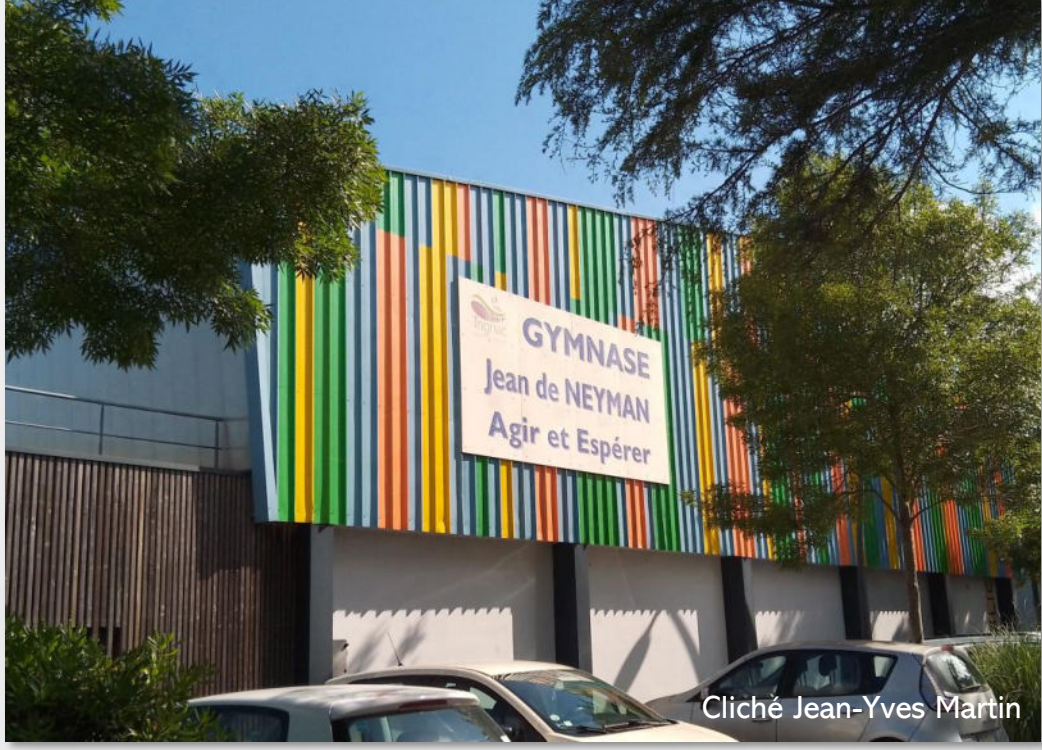
Gymnase Jean de Neyman à Trignac
